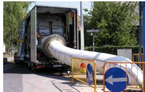
Монтажное устройство для локального ремонта повреждённых участков трубопровода
