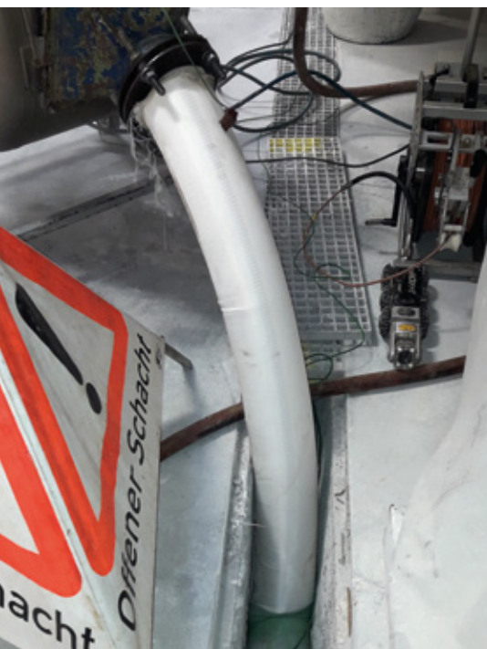
Speziell für kleine Dimensionen kann der NORDIWALL Flex Lite effektiv und wirtschaftlich eingesetzt werden
